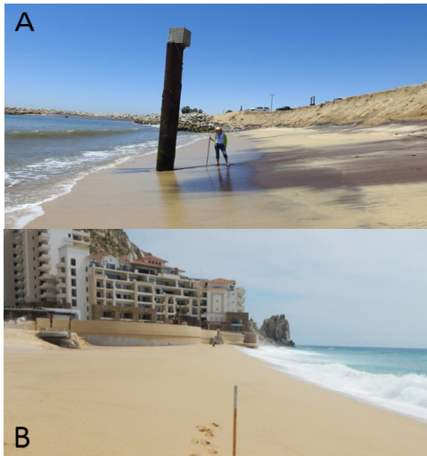
Fig. 5. Erosión por infraestructura costera. (A) Las Playitas, localidad al norte del espigón de protección al canal de ingreso al Puerto Los Cabos (al fondo de la fotografía), en donde la erosión ha provocado un retroceso de la línea de costa de aproximadamente 80 m en 12 años, desde que se construyó el espigón; al frente de la foto aparece una alcantarilla, vestigio de una calle desaparecida. (B) Muro de un hotel en la playa Finisterra localizada en la punta sur de la península; nótese el escarpe que dejó el huracán “Odile” (2014).
