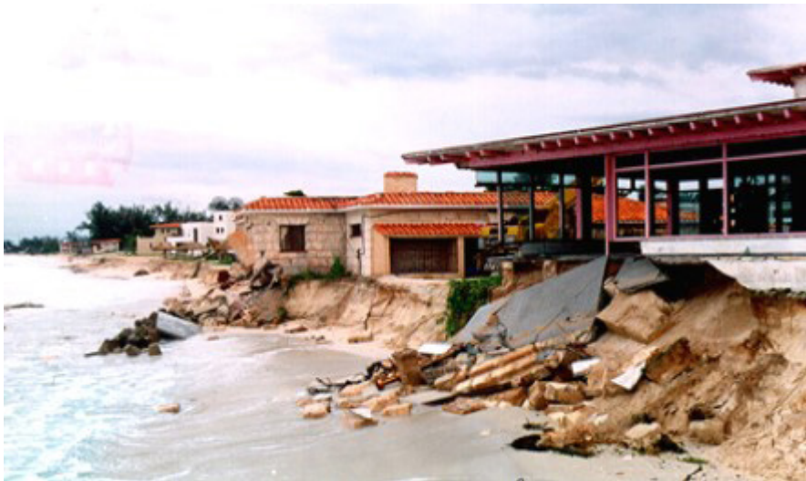
Fig. 1. Instalaciones turísticas ubicadas sobre la duna en Punta Blanca, Varadero, Cuba, dañadas por las olas generadas al paso del huracán Lili en septiembre de 1996.
