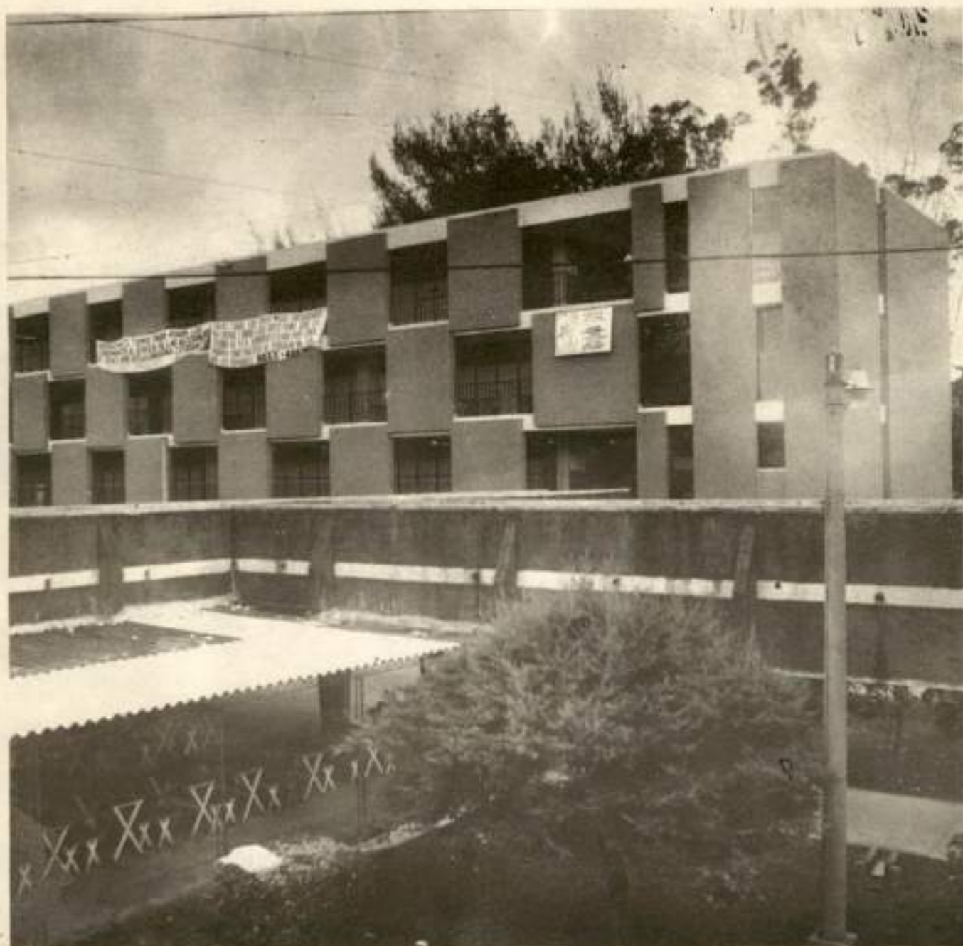
VISTA PARCIAL DE LOS EDIFICIOS DE LA FACULTAD DE CIENCIAS ECONOMICAS DE LA UNIVERSIDAD DE EL SALVADOR.
