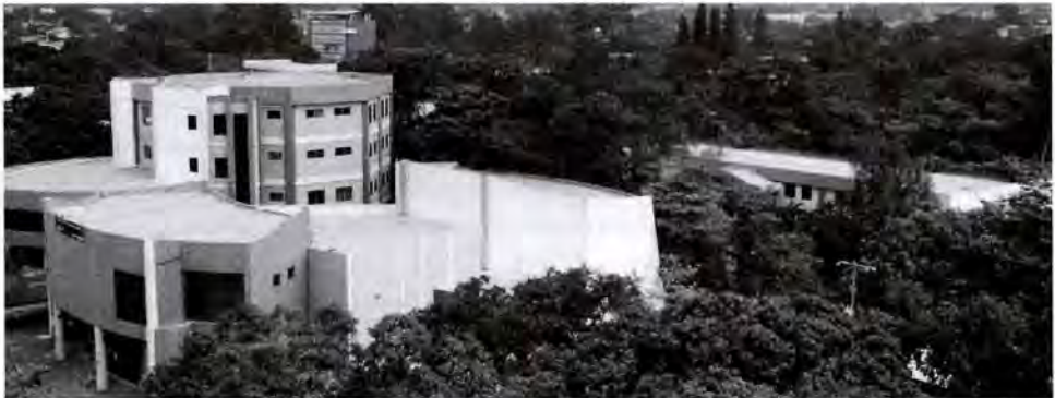
Edificios nuevos de la UES, fruto de la remodelación del año 2002. Imagen del Archivo de la Secretaría de Comunicaciones de la UES.
