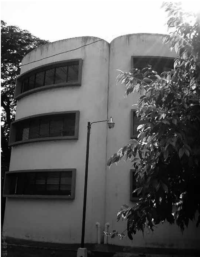
Figura 6. Edificio conocido como Bunker mediados de la segunda década del siglo XX, usado en el ejercicio docente construido entre 1966-1978
