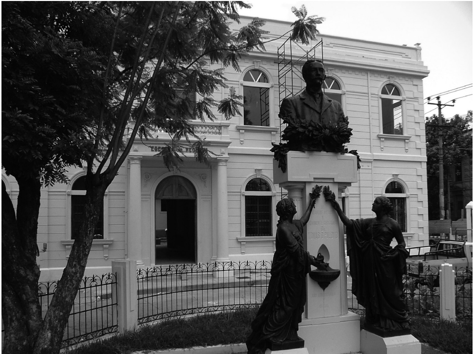
Antiguo edificio de la Facultad de Medicina conocido como «La Rotonda».
