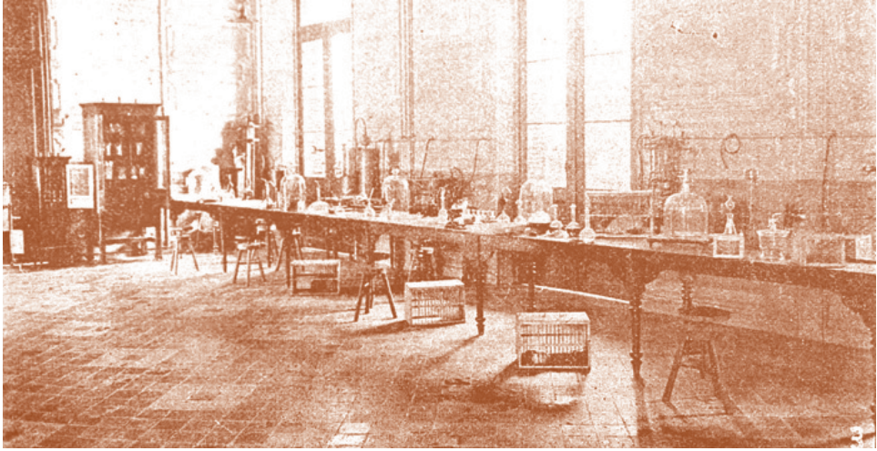
Arriba: Vista del Laboratorio de Química UES.
