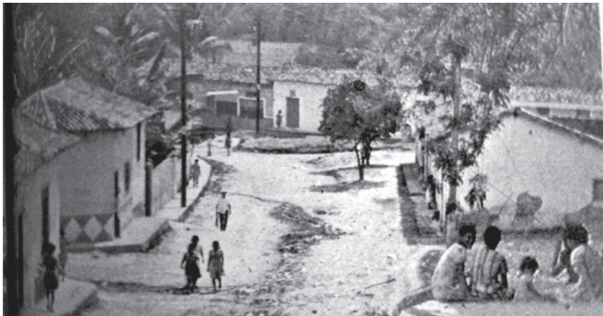
Figura 1. La calle José Ciro Mora del Barrio Concepción
