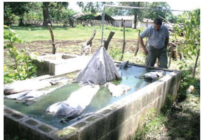
Figura 2. Biodigestor con el plástico cobertor dañado.
