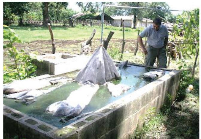
Nota: Biodigestor colapsado debido al inadecuado diseño que se llevó a cabo, el plástico cobertor no soportó la presión del biogás. Fuente: fotografía de ASOCIACIÓN FUNDACIÓN PARA LA COOPERACIÓN Y EL DESARROLLO COMUNAL DE EL SALVADOR (CORDES), (2012).
